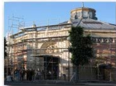
シャロン (2005年6月現在工事中)
